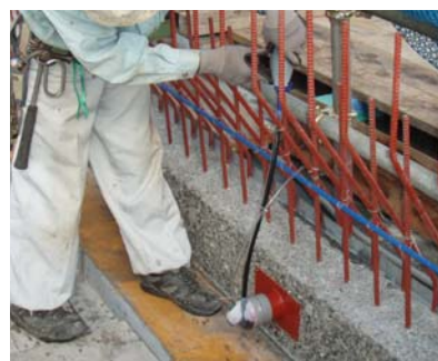
エポキシ樹脂注入状況
